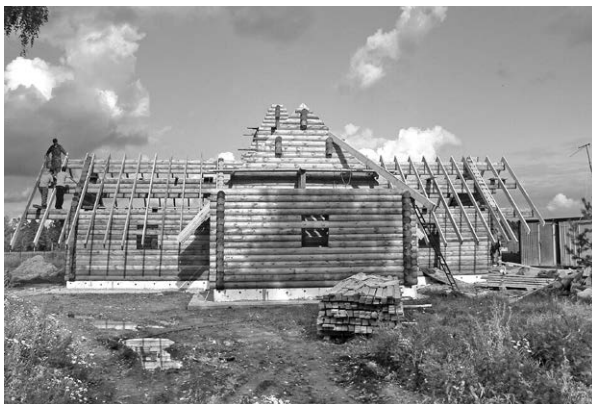
Строительство Приходского дома
